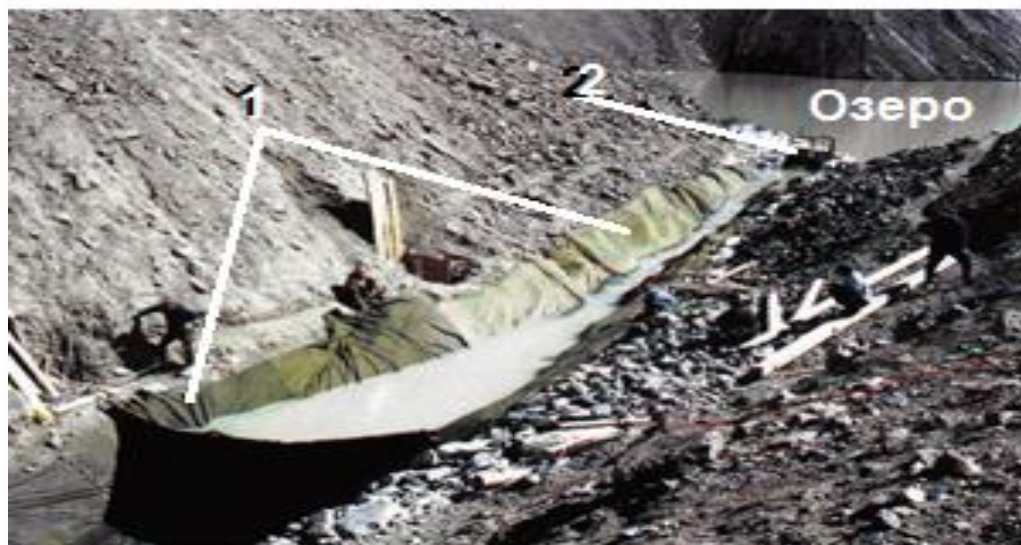
Рисунок 5.2 – Работы на озере №6 у ледника М. Маметовой в бассейне р. Киши Алматы (Медеу, 2011). 1 - брезентовый экран; 2 - мягкий затвор.
