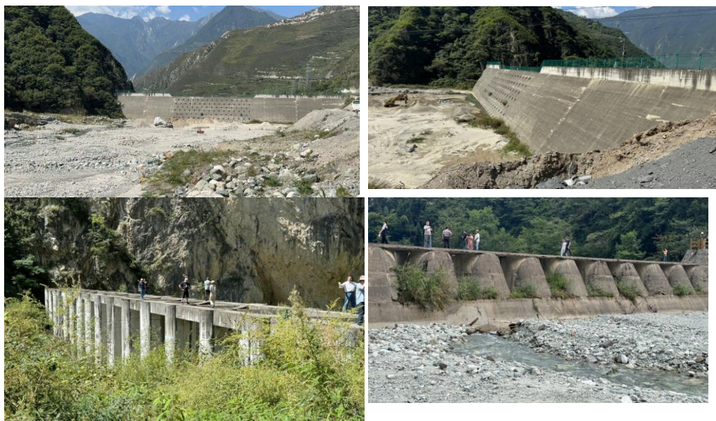
Рисунок 5.5 – Противоселевые барьеры в провинции Сичаунь, КНР. Фото Сафарова М.С.
