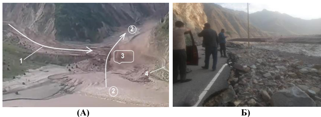
Рисунок 3.17 – А - момент схода селя: 1-селевой поток, 2-русло реки Сурхоб, 3- автодорога, 4-зона перекрытия русла рек Сурхоб. Б - разрушенная автомобильная дорога после схода селевого потока в Лахшском районе. (Источник: интернет ресурсы).
