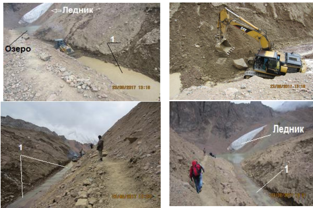
Рисунок 5.4 –Прокладка эвакуационного канала (1) для опорожнения приледникового озера с использованием экскаватора и бульдозера. Фото Фазылова А.Р. (23.08.2017г.) (Фазылов и др., 2024)
