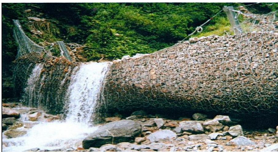
Рисунок 5.6 – Облегченное гидротехническое противоселевое сооружение
