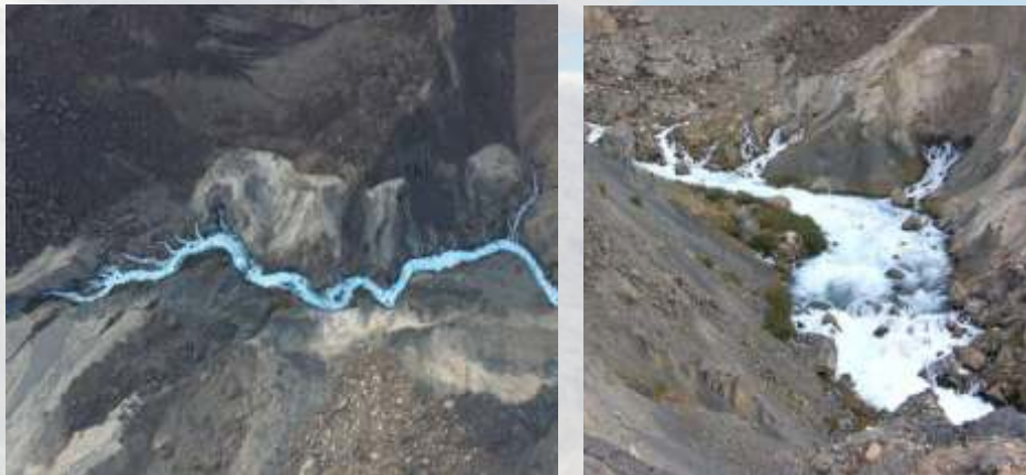
Фильтрация воды с озеро через тело плотины посредством источников / Filtration of lake water through the body of the Usoy dam via powerful springs.
