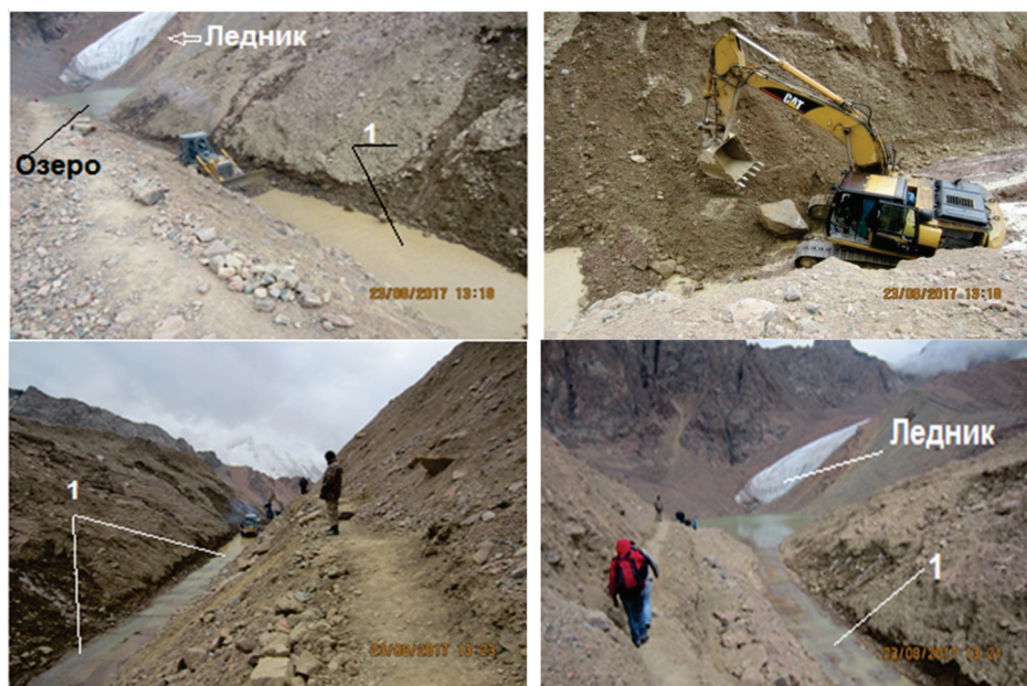
Рис. 5. Прокладка эвакуационного канала (1) для опорожнения приледникового озера с использованием экскаватора и бульдозера. Фото А.Р. Фазылова (23.08.2017 г.).
